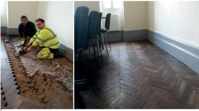
Réfection du parquet de la salle du Conseil
