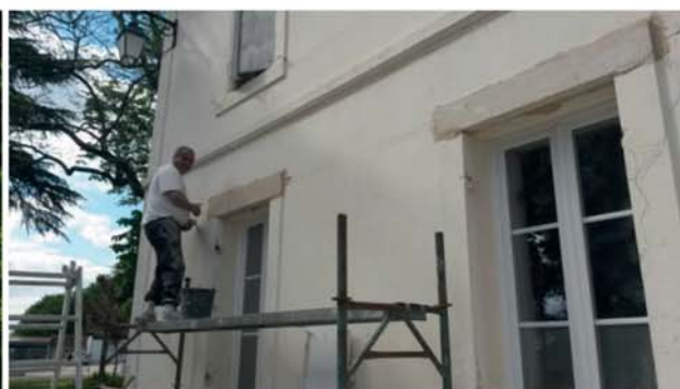
Remerciements à Mohamed Bouziane tailleur de pierres pour la réparation gratuite de la Mairie
